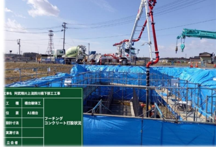
②A1橋台(コンクリート打設状況)
